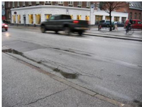
Foto B1: Vand på kørebanen
