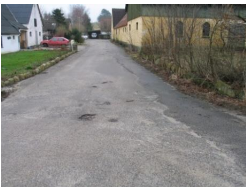
Eksempel 3. Trafikklasse T1 - Restlevetid: 16 %, Efter udbedring af slaghuller og afskalning kommer restlevetiden op på 20 %.
