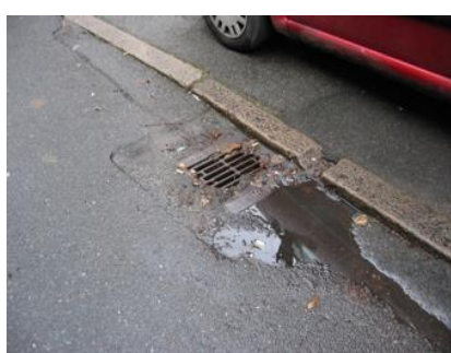
Billede B2: Langsgående revner og rendestensriste.
