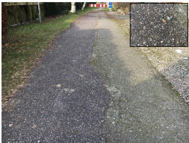
Foto 10. Stitilstand uacceptabel , Sti Grønhøj til Snur-Om, 92 meter lang, hovedeftersyn 2015, foto fra 2017.
