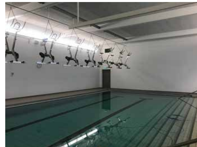
Sport- und Kulturzentrum, bassin
