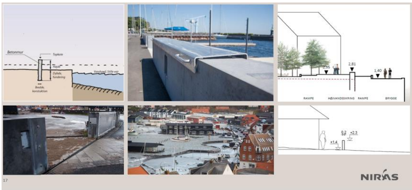
Figur 2.4: Højvandsmur med højvandsslukker fra Lemvig og Hellerup Havn samt forslag fra Køge og Enø
