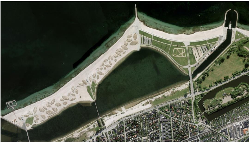
Figur 2.5: Amager Strandpark med ind pumpet sand, sluse og flere rekreative indslag
