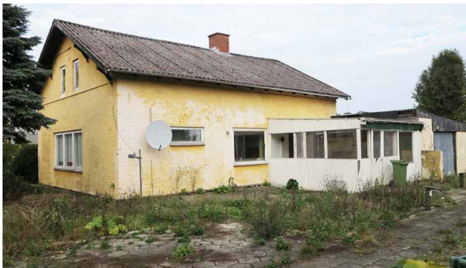
Der er nu indgået aftale med ejeren om køb og nedrivning af ejendommen Løjt Skolegade 19.
