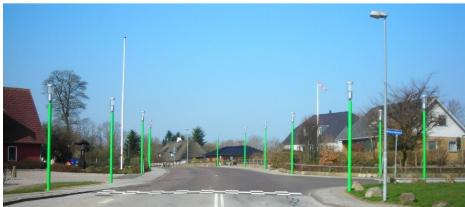
Belysning ved Genner skole med Philips, City Spirit Torch på mast med lysgrøn indfarvning.
