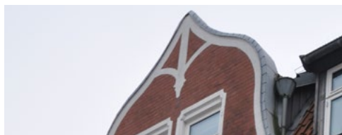
Storegade 20, 1906. Gavlkvistens pudsede detaljer er ren dekoration og symboliserer intet konstruktivt som historicismens murede gesimser gør det.
