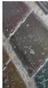
Skibbrogade 7, 1900. Glaserede sten er brugt til sålbænke.
