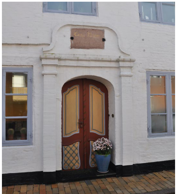
Slotsgade 3, 1744-54. Dørportal med pilastre og svunget overprofil, udført af tilpassede tegl. Tavle i natursten fastholdt med ankre.
