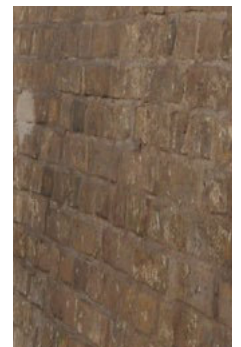
Kirkepladsen 8. Berapning/sækkeskuring med en lerbehandling.
