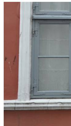
Fiskergde 8. Gennemgående pudset sålbænk med profil.
