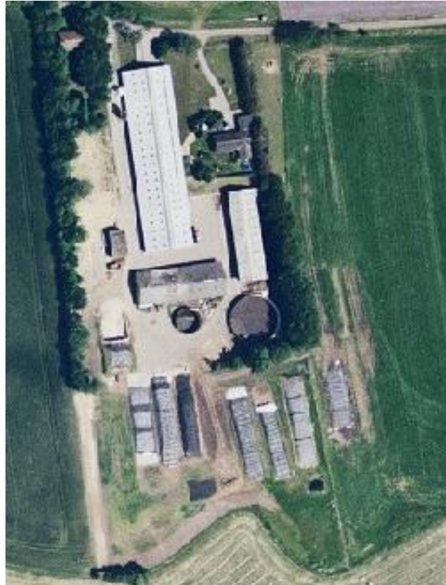
Luftfoto af ejendommen (copyright DDO ®, ©COWI)
