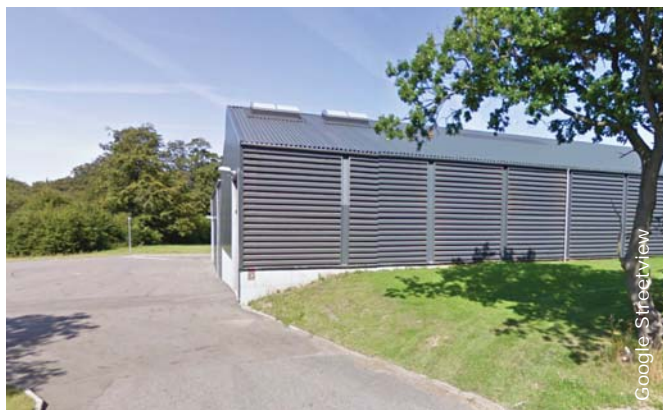
Det eksisterende fjernvarmeverk set fra den sydlige vejadgang til Skovbyvej
