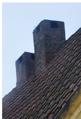
Nygade 33. Enkle skorstenspiber uden gesimsled.
