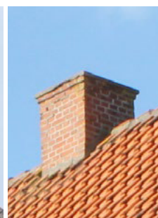
Bjerggade 8, enkle 'nyere' skorstenspiber uden sokkel og udkrægning.
