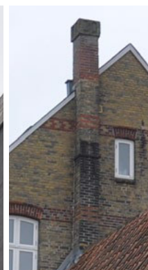
Storegade 7, skorstensløbet på baghuset er muret med samme mønstermurværk som huset.
