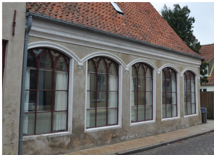
Slotsgade 24. Oprindelige store støbejernsvinduer.
