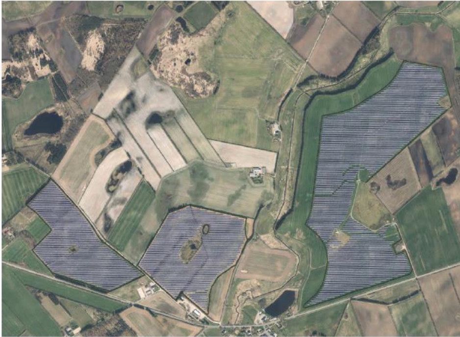
Fig. 1: Projektskitse af områdets indretning. For detaljeret indretning af anlægget henvises til kortbilag 2 i Lokalplan nr. 136.
