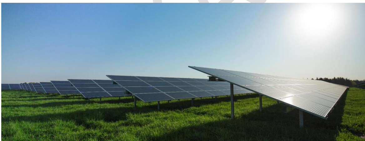
Eksempel på faste solpaneler med matgrå overflade på græsarealer.
