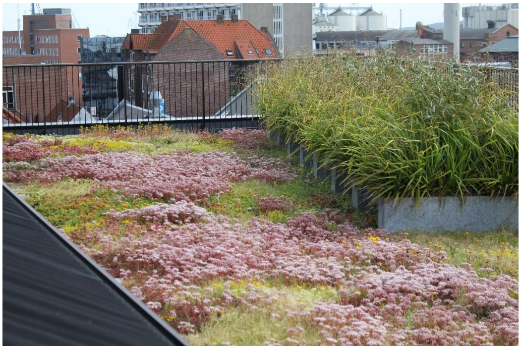
Figur 6-1 Grønne tage kan optage og forsinke udledningen af store mængder regnvand og dermed aflaste kloaksystemet (foto: COWI/Lars Brøndum).
