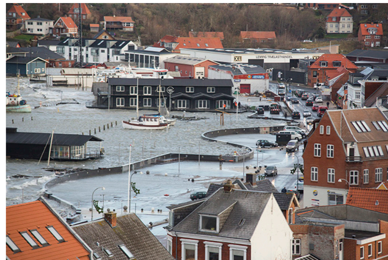
Figur 5.4 Eksempler på højvandsmur med højvandsslukker fra Lemvig og høj promenade Bo01 i Malmø (eksempel fra Hasløv & Kjærsgaard)
