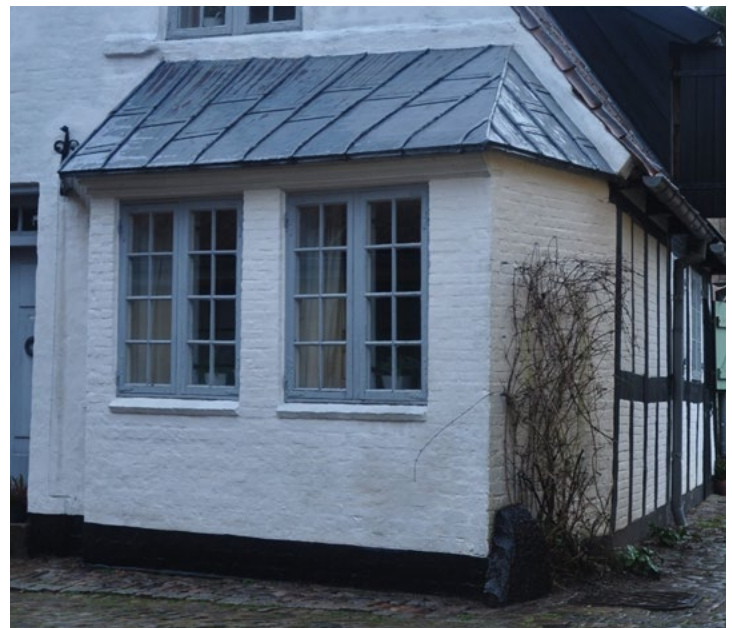
Jomfrugangen 1a. Karnappen er tækket med bly. Mødet mellem murværk og tagdækning er forskælet fint ind i murværket.
