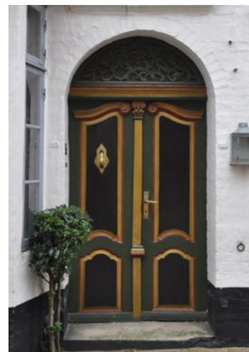
Slotsgade 29, 1770. Fyldningsdør med svungne profiler og sirligt udkåret overvindue.
