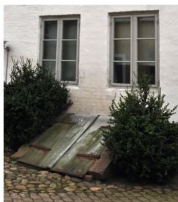
Kældernedgang med afdækning af skråstillede lemme, der hviler på trappens vanger.
