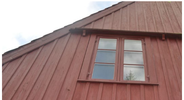
Slotsgade 24. Listebeklædt gavl med enkel sugfjæl/vindskede og vandbrædder over vinduerne båret af konsoller.
