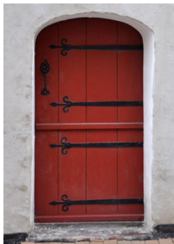
Gildegade 5. Nyere men traditionelt udført todelte revledør med smedede båndhængsler med bukkehorn.
