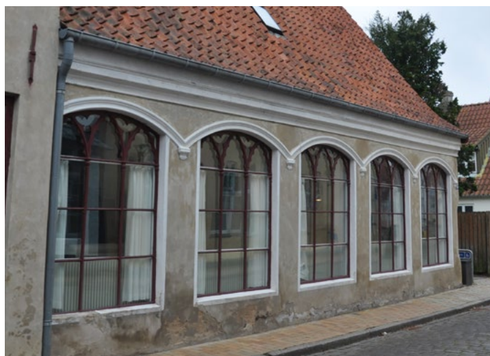
Slotsgade 24. Oprindelige store støbejernsvinduer.
