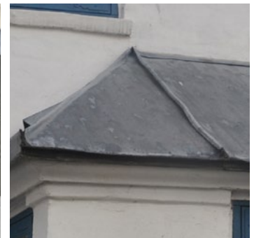
Slotsgade 23. Blytag med liggende fals.
