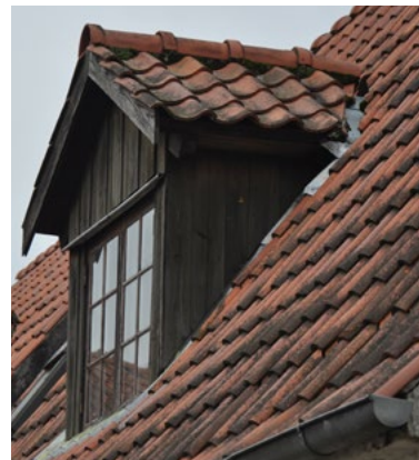
Slotsgade 6. Heltagskvist med tegl og bræddebeklædning.
