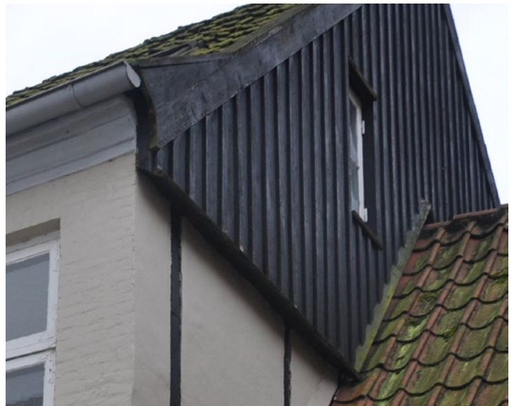
Skibbrogade 20. Listebeklædt gavl over bindingsværksmur. Enkelt sugfjæl/vindskedebrædt er skæet i profil der følger gesimsen på hovedhuset.
