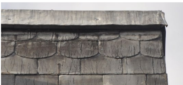
Nybro 22. Rygning på skifertaget er over de tungede skifer afdækket med bly. Denne type dækning bør vedligeholdes og fortsættes når den findes. Alternativt benyttes zink.
