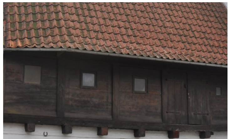
Eksempel på baghus med bulkonstruktion. Behandlet med trætjære.
