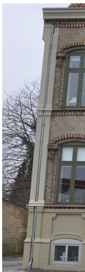
Nyvej 3. Nedløbsrøret er indtænkt i bygningens symmetri og lagt i reces i murværket bag gesimsen.
