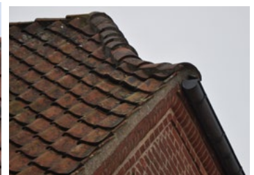
Slotsgade 15 og Slotsgade 31. Rygningen er lagt i mørtel og vingeteglene er lagt ud over de fritstående gavlmure. Afslutningerne er byggetraditionelt enkle, giver et godt helhedsindtryk og er simple at vedligeholde. Ved vedligehold skal man være opmærksom på løse sten, at løst mørtel fjernes, at underlaget sikres og renses for evt. alger. herefter påføres ny mørtel.
