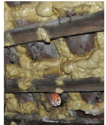
Understrøget tag med skum-produkt. Produktet er uæstetisk og svært at styre, ofte rejser tagstenene sig ved denne metode, ligesom genbrug ikke er muligt.
