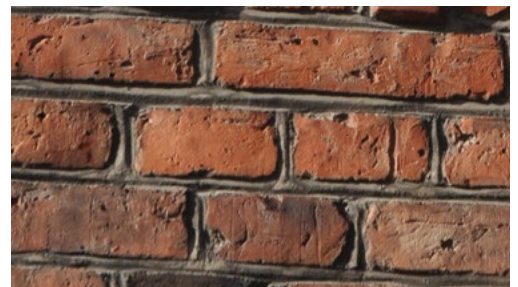
Storegade 18, 1911-12. Brændte fuger med staf.
