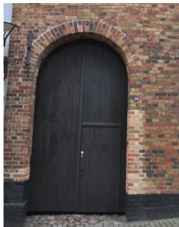
Storegade 24. Tofløjet port med adgangsdør i ene portfløj
