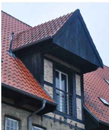
Skolevej 7. Pakhusets hejskvist, med let konstruktion i bindingsværk og breddebeklædte flunke er omdannet til have vindueshul.
