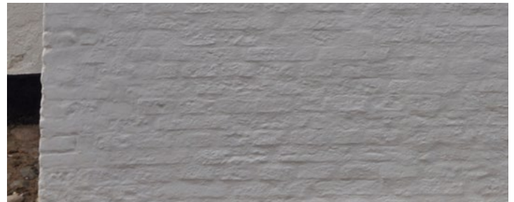
Nybro 14. Grundmuret og kalket gavl fra 1781. Stenenes blødsrøgne og uregularitet anes gennem kalkens stoflige og bløde overflade.
