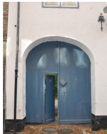
Skibbrogade 8. Tofløjet port med adgangsdør i ene portfløj
