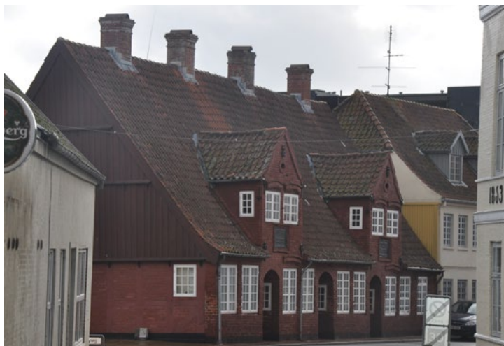
Sønderport 1, Schwennesens stiftelse, fire markante skorstene markerer tagryggen, her med blyinddækning.
