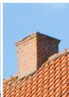
Bjerggade 8, enkle 'nyere' skorstenspiber uden sokkel og udkrægning.
