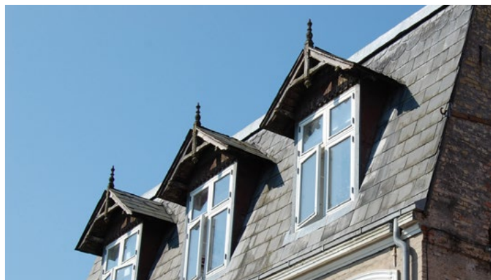
Nybro 22, tagfladen og kvistene er tækket med skifer.
