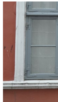
Fiskergde 8. Gennemgående pudset sålbænk med profil.
