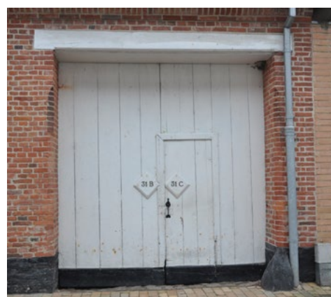
Slotsgade 31. Tofløjet port med adgangsdør i den ene portfløj. Bemærk portoverligger i tømmer og de fint affasede hjørner i murværket.
