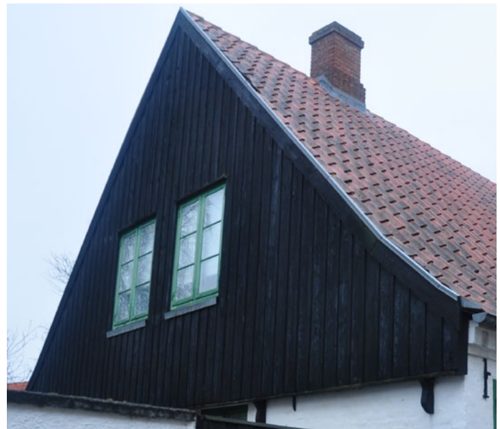
Lille Pottergade 4. Lodret brædebeklædning en-på-to, med enkelt sugfjæl/vindskedebrædt og vandbrædt over den murede gavfacade, der bæres af profilerede konsoller i træ.
