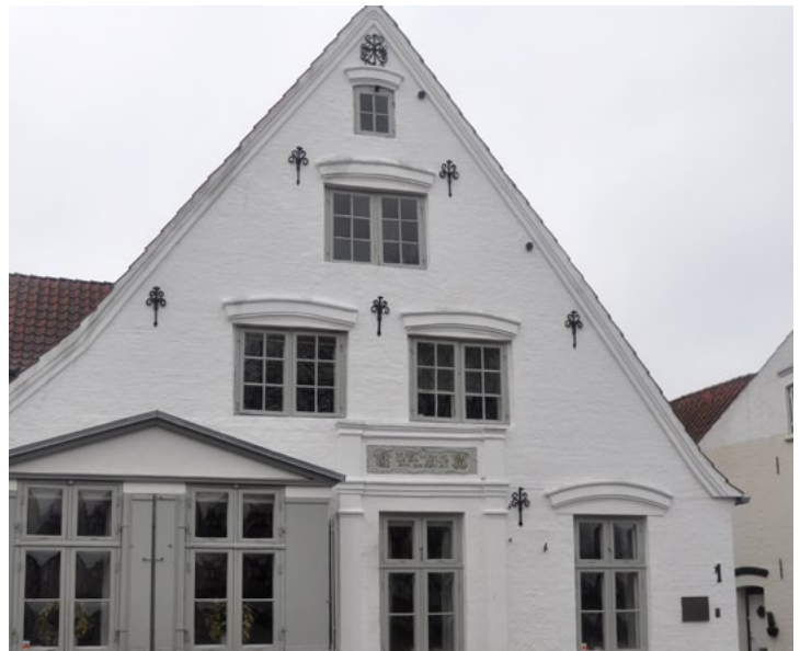
Klinkbjerg 1, 1767. Fire rækker af murankre over hinanden. Tre rækker er liljeformede, mens ankeret i toppen har en rigere udformning.
