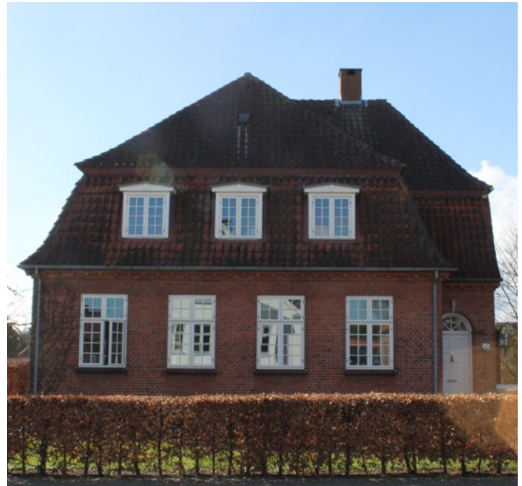
Callesensgade 8, Heltagskviste med lav taghældning, tækket med zink. Placeringen af kvistene underordner sig tagets form og facadens vinduesplacering. Rudeformater er ens.
