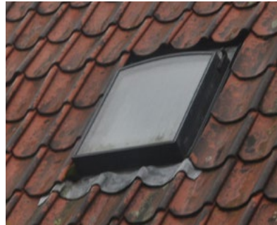
Nybro 3. Enkelt tagvindue placeret lavt i tagfladen og med skjulte inddækninger. Bredden af tagvinduerne er tre tagsten ligesom højden.
