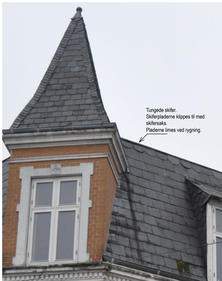
Nørreport 14. Tårnets tag er tækket med mindre skiferformat. Små skifer langs tårntagets kanter er dekorativt tungede, ligesom kvistens flunker, og øveste række skifer på tagfladen.
