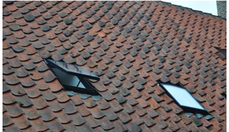
Slotsgade 24. Enkle tagvinduer placeret lavt i tagfladen, og med skjulte inddækninger. Bredden af tagvinduerne er tre tagsten ligesom højden.
