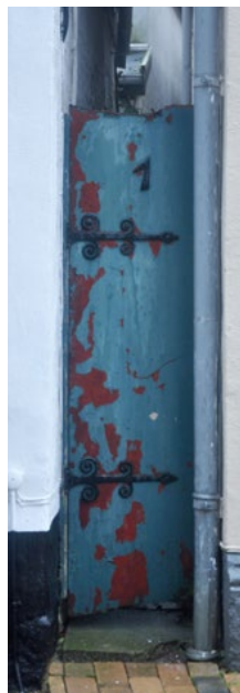
Låge til slippe i Lille Pottergade med smedede detaljerede båndhængsler.
