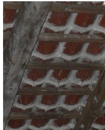
Understrøget tag med mørtel. Mørtlen holdes under opsyn, og eventuelle skader udbedres med ny mørtel. Tagsten kan genbruges ved omlægning
