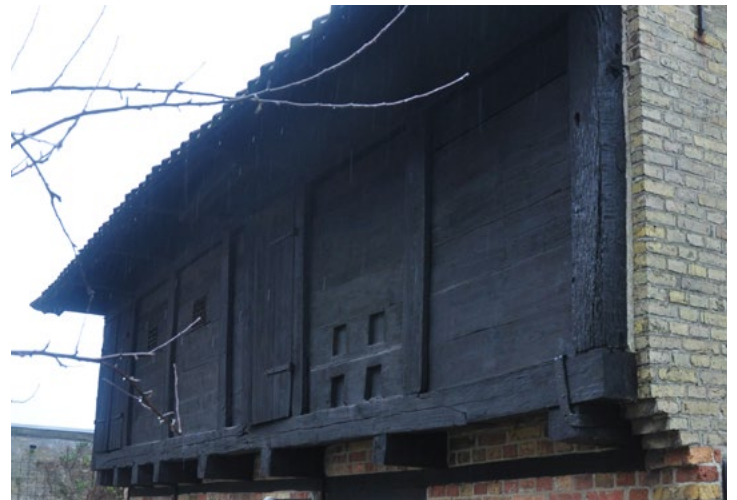
Baghuset bag Klinkbjerg 2. hus. Andet stokværk i bulkonstruktion. Bulhusets fleksible fagdeling ses her, med små luger og lem.
