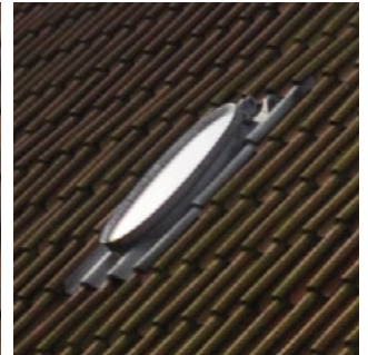
Slotsgade 9. Enkelt ovalt tagvindue placeret lavt i tagfladen og med skjulte inddækninger.
