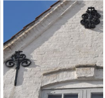
Nybro 14, gavl grundmuret 1781. Detaljerede liljeankre, hvor gavlkvistens er 'dobbelt' og mere rigt detaljeret. Dette træk ses flere steder i byen.
