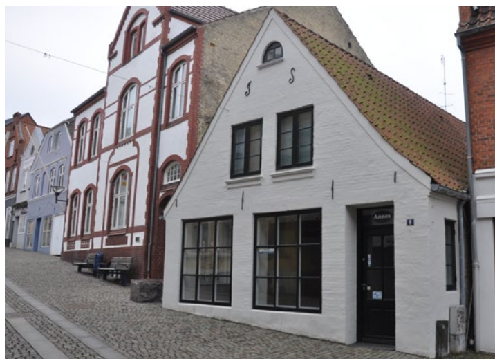
Ramsherred 6. Butiksvinduerne er holdt i samme farver som resten af facadens elementer.
