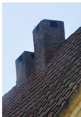
Nygade 33. Enkle skorstenspiber uden gesimsled.
