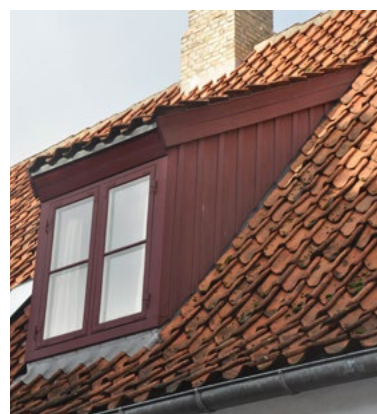
Slotsgade 24. Pultkvist, opbygget omkring stolpekarm. Listebeklædt og enkle sugfjæl.
