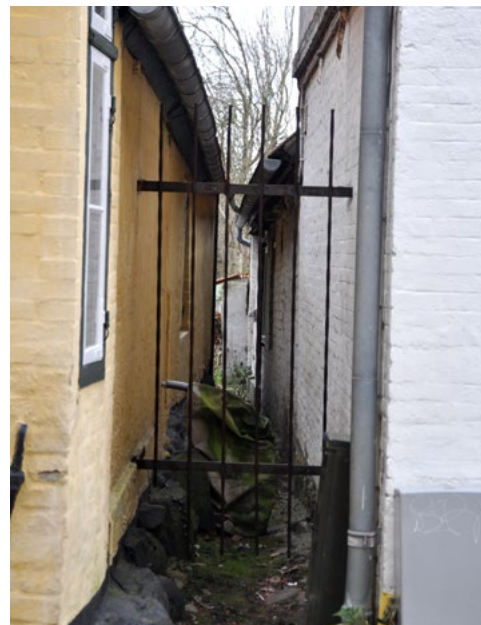
Slotsgade. Enkelt smedet gitter til slippe.
