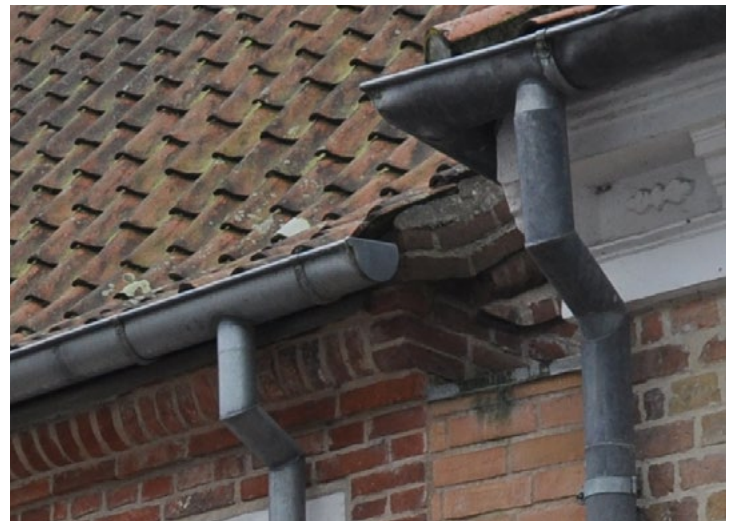
Tagrende og nedløbsløsninger udført med bajonetknæ.
