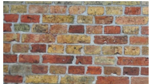
Wollesgyde 10, 1754-64. Røde og gyldne tegl er kendetegnende for det ældste murstensbyggeri i Aabenraa. Fugerne er udført som skræbefuger.
