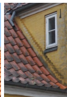
Nygade 44. Inddækning mellem kvist og tag udført som "musetrappe".
