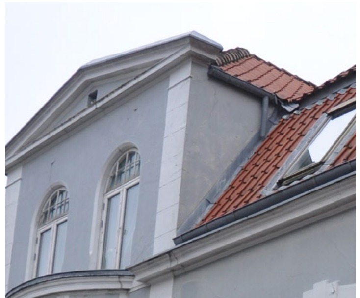
Ramsherred 47. Ved galvkvist med fritstående gavlkam og mansardtag er der flere afvandsproblematikker der skal tages stilling til. Her fint løst med diverse zink-løsninger.
