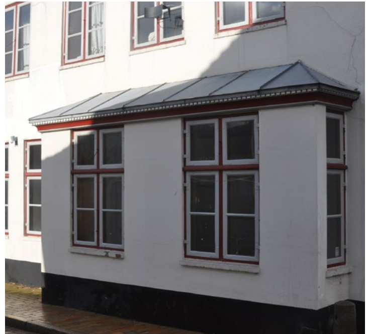
Slotsgade 30. Zinktækket karnap med stående fals.
