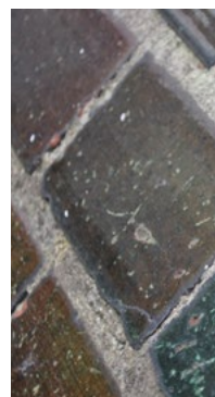
Skibbrogade 7, 1900. Glaserede sten er brugt til sålbænke.
