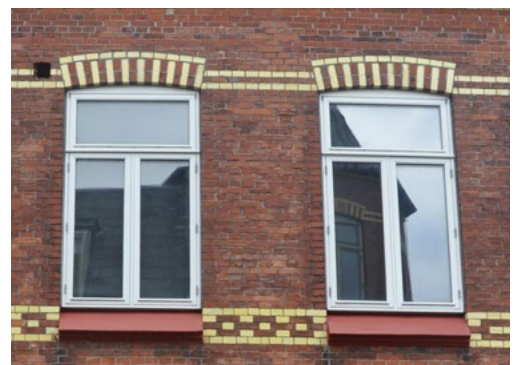
Callesensgade 27-29, 1903. Glaserede sten bryder det blanke murværk med dekorative vandrette bånd og stik over vinduerne.
