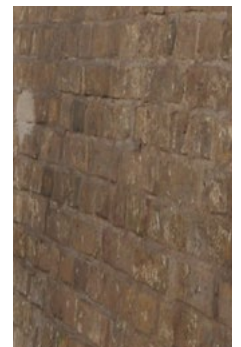
Kirkepladsen 8. Berapning/sækkeskuring med en lerbehandling.
