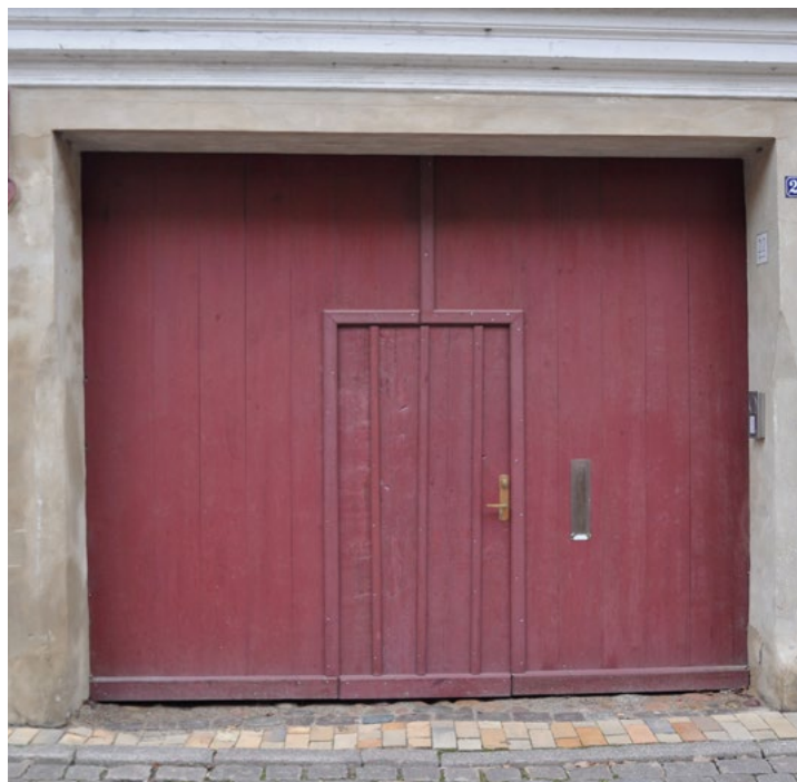
Slotsgade 24. Bred port med adgangsdør i midten. Hvis revleporte slår revner kan man påsætte lister over revnerne.
