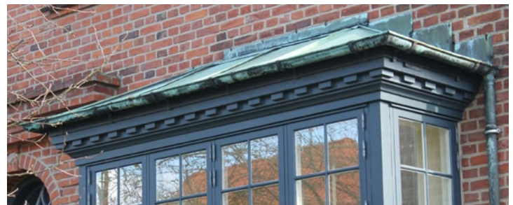
Kirkebakken 2. Karnap med kobbertag. Inddækningerne er lagt ind i murværket ved aftråning der følger murværket.
