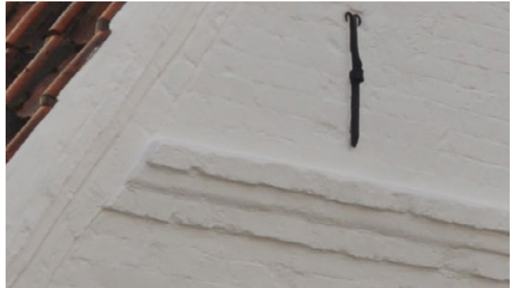
Slotsgade 9, 1710. Gesims med kvartrundt skifte mellem to rektantede skifter.
