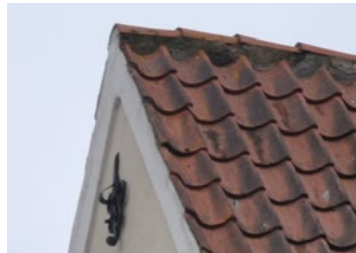
Slotsgade 15 og Slotsgade 31. Rygningen er lagt i mørtel og vingeteglene er lagt ud over de fritstående gavlmure. Afslutningerne er byggetraditionelt enkle, giver et godt helhedsindtryk og er simple at vedligeholde. Ved vedligehold skal man være opmærksom på løse sten, at løst mørtel fjernes, at underlaget sikres og renses for evt. alger. herefter påføres ny mørtel.
