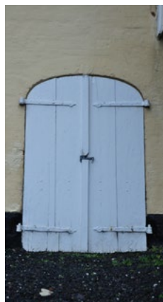
Ramsherred 45c. Mindre port/luge med udvendige stabler og båndhængsler.
