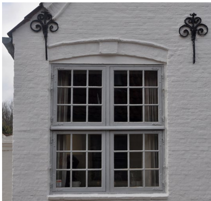
Nybro 14. 1700-tals korspostvindue med fire lige store rammer.
