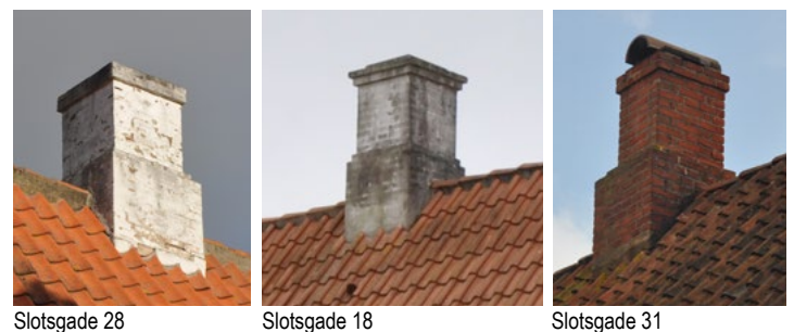
Den typiske danske skorstenspipe før 1950. Skorstenspiberne kan have dekorationer med kamtakker, murede bånd, blændinger eller spejl.
