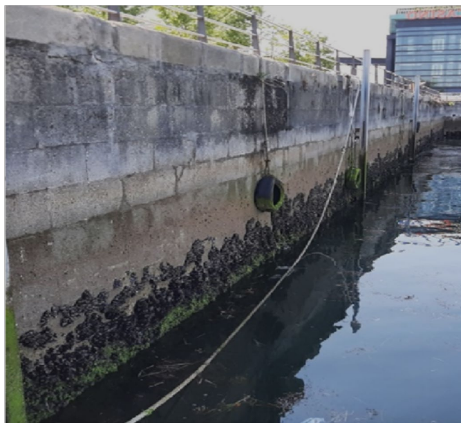
Figur 2.4.3: Typisk havnevæg, som erstatter den naturlige overgang mellem land og hav i de fleste havneanlæg.
