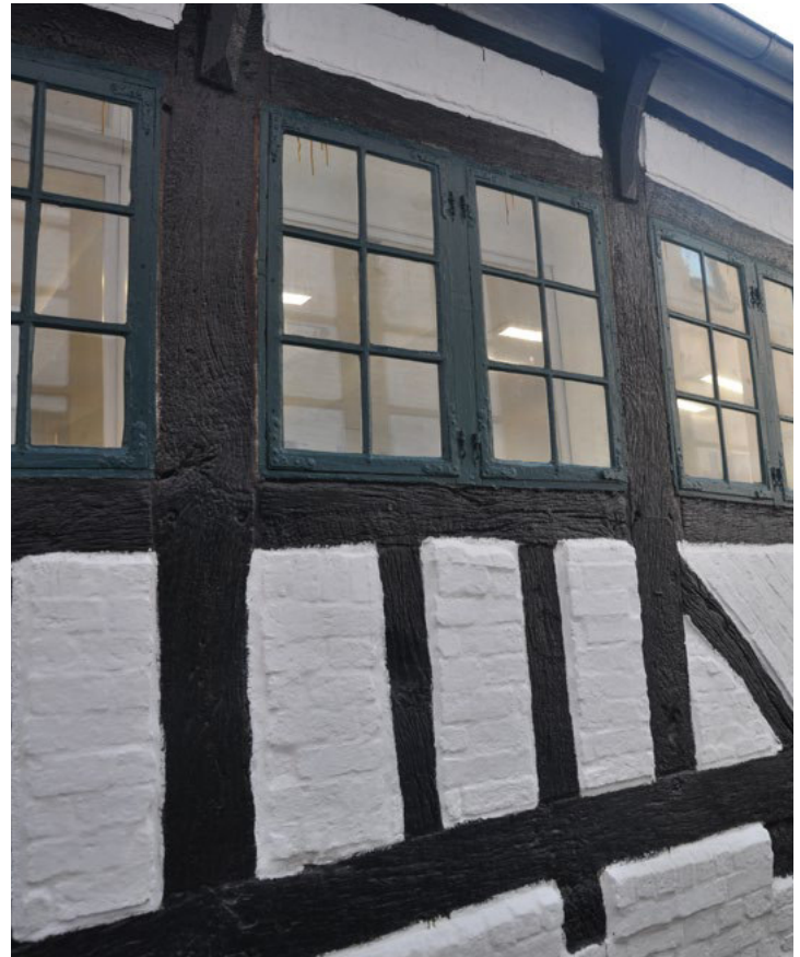
Storegade 11, bevaret bindingsværk fra 1600-tallet. To dokker under hver løsholt, tømmer i store dimensioner (se midterstolpen på gavlen) og profilerede knægte.
