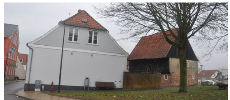
Klinkbjerg 2 og Wollesgyde 10, 1757-1764. Baghuset er et af de få bevarede eksempler på bulhusbyggeri i Aabenraa. Baghuset er istandsat inden for de senere år og repræsenterer en bygningstype, der tidligere har været meget almindelig i Aabenraa, men nu nærmest er helt forsvundet. Man ser her fint, hvordan bulhuset indpasser sig som baghus/tværhus til forhuset mod Klinkbjerg.
