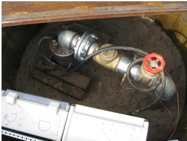
Foto indefra: Boring i overbygning
