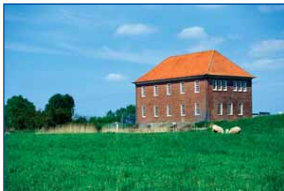
Pumpestation ved Lægan
