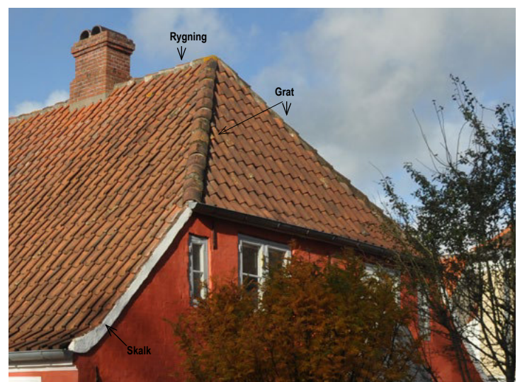
Kirkepladsen 7. Vingeteglene er lagt ud over gavlen med ca. to cm's udkragning. Bemærk knækket/skalken der afbløder regnvandets fart på vej mod tagrenden. Rygning og grater er lagt i mørtel.
