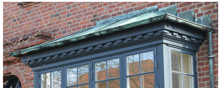
Kirkebakken 2. Karnap med kobbertag. Inddækningerne er lagt ind i murværket ved aftråning der følger murværket.
