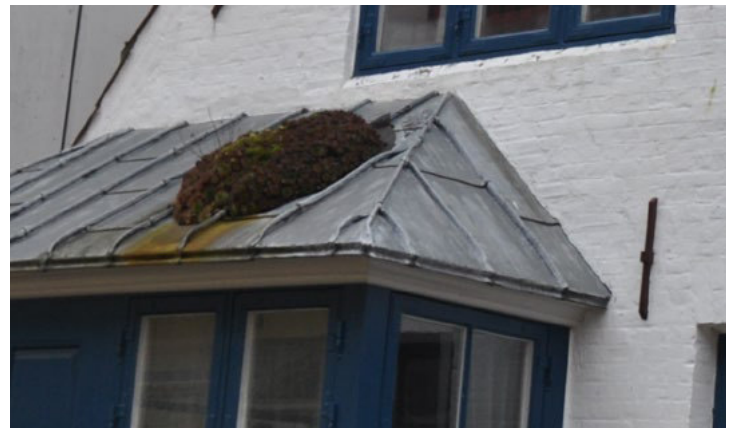
Fiskergade 3. Karnappen er tækket med bly. Mødet mellem murværk og tagdækning er forskælet fint ind i murværket.
