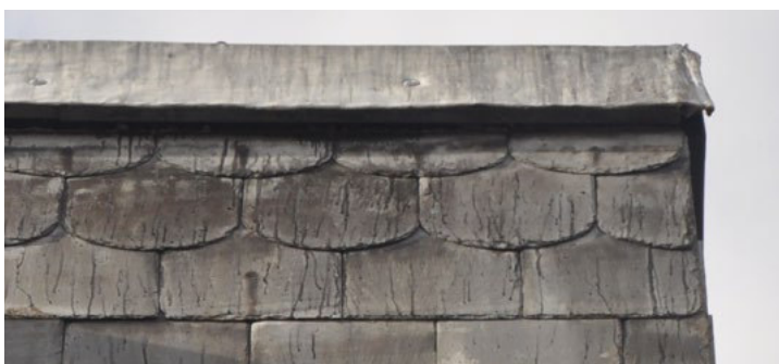
Nybro 22. Rygning på skifertaget er over de tungede skifer afdækket med bly. Denne type dækning bør vedligeholdes og fortsættes når den findes. Alternativt benyttes zink.
