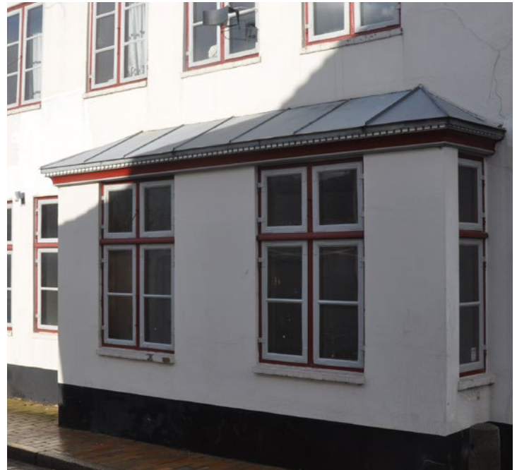
Slotsgade 30. Zinktækket karnap med stående false.
