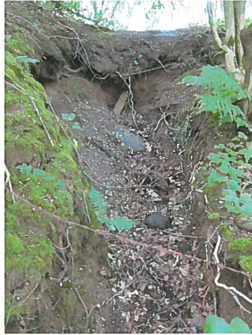
Skrænten er udhulet pga. afstrømning
