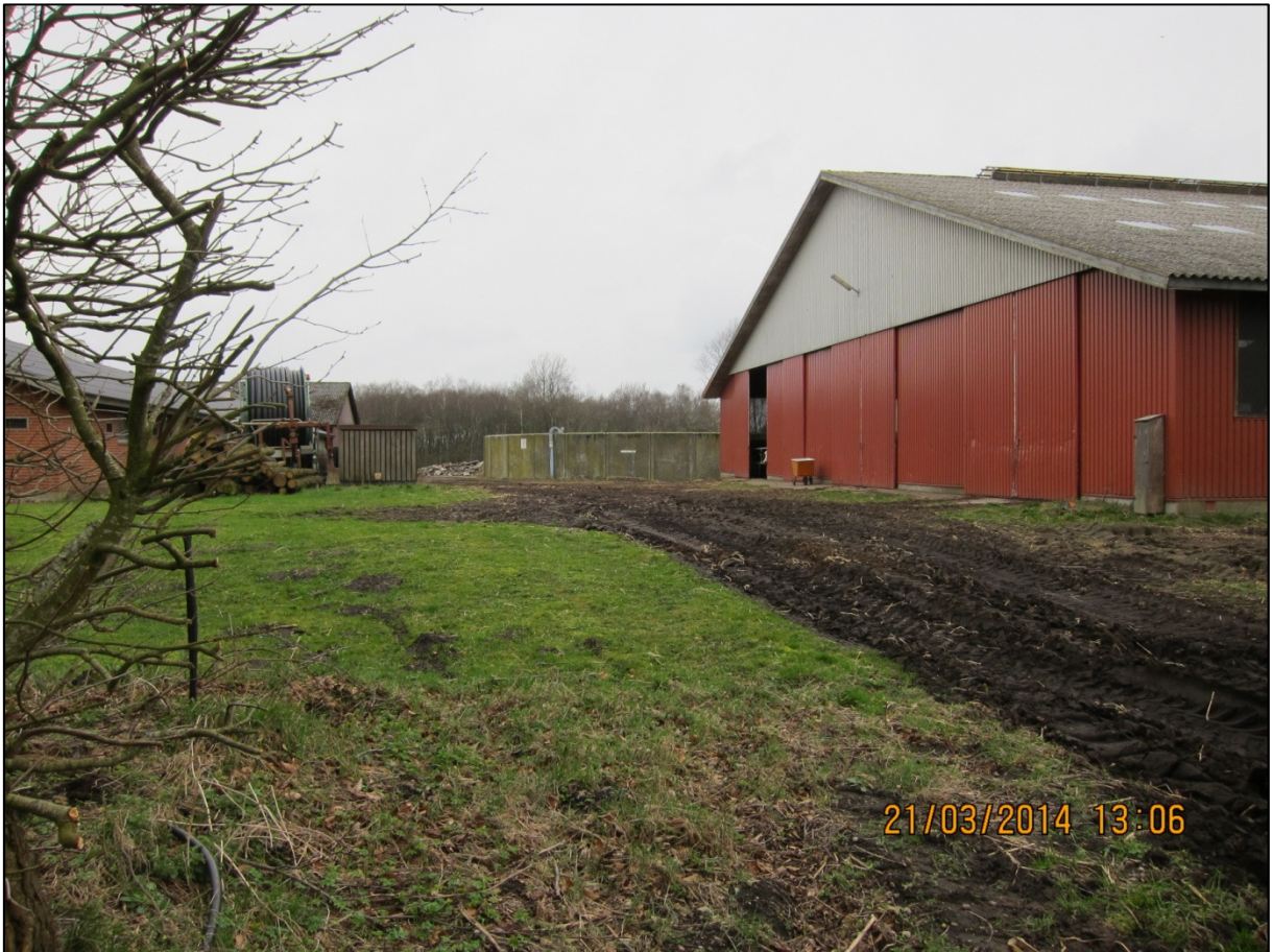
Foto 1: Anlægget fra nordvesthjørnet af Nørrebækvej 17's matrikel.
