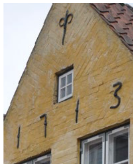
Slotsgade 15, 1713. De nok ældste murankre som tal i byen. Murankret i gavlkvistens med en enkel liljeform er et af de ældste i Aabenraa.
