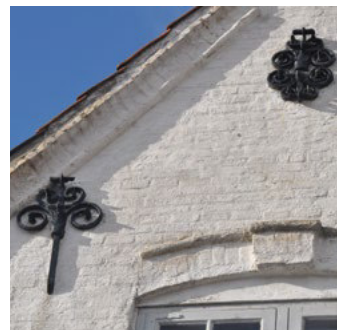
Nybro 14, gavl grundmuret 1781. Detaljerede liljeankre, hvor gavlkvistens er 'dobbelt' og mere rigt detaljeret. Dette træk ses flere steder i byen.
