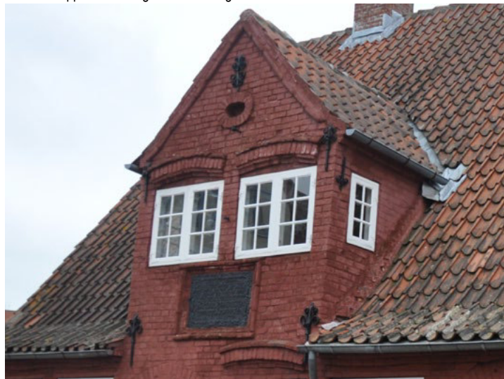
Sønderport 1, Schwennesens stiftelse, 1772. Liljeformede murankre i smedejern og hustavle i støbejern.
