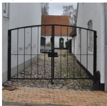
Skibbrogade. Smedet enkel låge til baggård.
