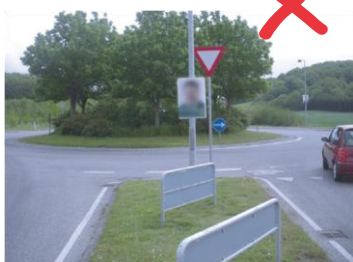
Ulovlig ophængning på midterhelle ved rundkørsel ved vej med tilladt hastighed over 60 km/h.
