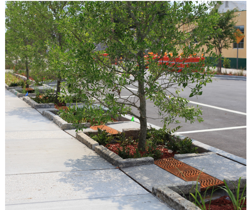
Eksempler på vandrender, beplantning og udsmykning i støbejern langs gadestrækninger i Portland, Oregon
