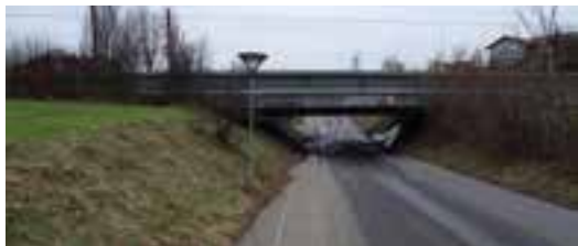
Tunnelen - jernbanen der deler byen i to
