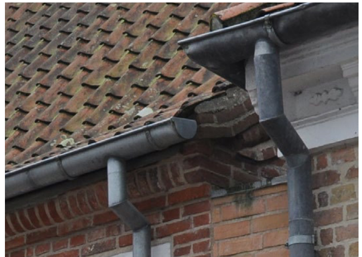
Tagrende og nedløbsløsninger udført med bajonetknæ.
