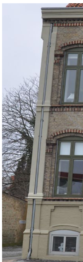
Nyvvej 3. Nedløbsrøret er indtænkt i bygningens symmetri og lagt i reces i murværket bag gesimsen.
