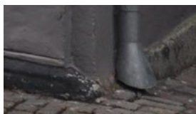
Ramsherred 45. Overgangen mellem nedløbsrør og brønd har form som en omvendt, let asymmetrisk tragt.
