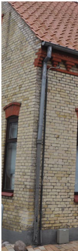
Gildegade gang 2. Bajonetknækket holder sig fri af gesimsen. Nedløbsrøret er ført til malet støbejernsrør.
