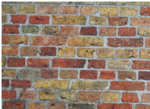
Wollesgyde 10, 1754-64, røde og gyldne tegl er kendetegnende for det ældste murstensbyggeri i Aabenraa.
