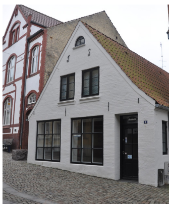
Ramsherred 6, gavlhuis oprindeligt opført i bindingsværk før 1744, ombygget i 1988. Grundmuret gavli med enkle klassicistiske detaljer mellem 1825 og 1835 for Jürgen Sørensen (Murankrenes initialer).
