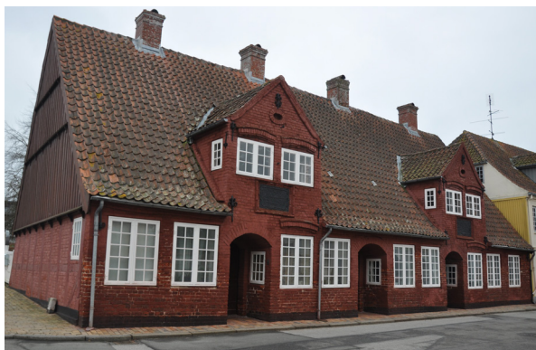
Sønderport 1, Schwennesens Stiftelse. Langhus med to gavkviste, grundmuret mod gadeside. Nordgavl og gårdside i bindingsværk. Opført i 1772.
