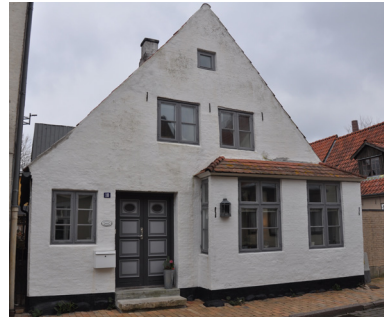
Slotsgade 10, opført efter Slotsgades brand i 1707 som et gavlhus i bindingsværk. Bindingsværket er udskiftet til grundmur fra omkring midten af 1800-tallet. Et fint barokt hus i sin grundform med karnap med bæverhaletag (nok også fra midten af 1800-tallet).
