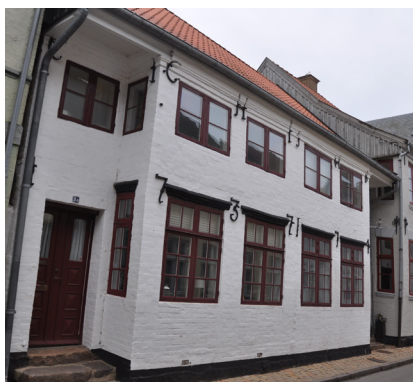
Skibbrogade 3 består af to sammenbyggede trefags langhuse opført i henholdsvis 1737 og 1748. Fremstår barokt i sit udtryk med karnap i to etager mod gaden og murankre med tal. Bindingsværk er bevaret mod gården.
