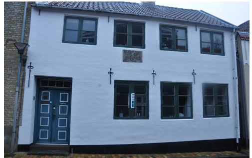
Lille Pottergade 1, opført 1745 i en etage med grundmuret facade. Mellem 1845 og 1855 forhøjes gadefacaden. Hoveddøren har tidligere siddet under hustavlén. Enkle murankre.
