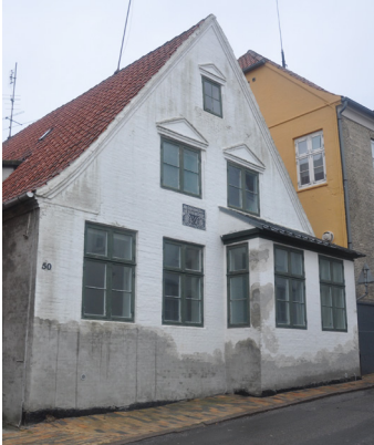
Nygade 50, 1748. Huset har flere barokke træk som karnappen og gesimsen. Men de murede trekantfrontoner over vinduerne er rokokotræk ligesom hustavlen.
