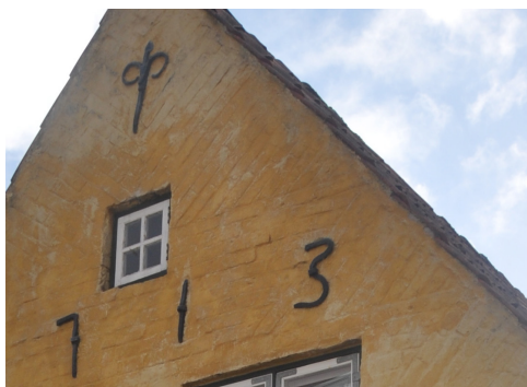
Slotsgade 15, 1713. Enkelt udformet lilemuranker i gavlkvisten og tal. Murværkets strømskifter anes gennem kalken som en række trekanter, hvis skifter af konstruktive hensyn står vinkelret på tagfladerne.
