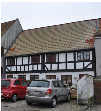
Skibbrogade 3 består af to sammenbyggede trefags langhuse opført i henholdsvis 1737 og 1748. Fremstår barokt i sit udtryk med karnap i to etager mod gaden og murankre med tal. Bindingsværk er bevaret mod gården.
