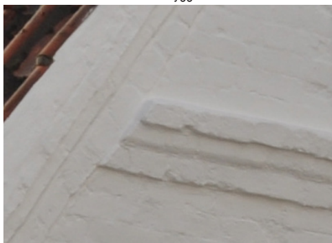
Slotsgade 9, 1710. Gesims med kvartrundet skifte mellem to rektangede skifter.
