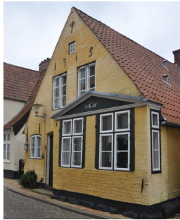
Slotsgade 15, 1713. Original grundmuret gavl mod gaden, bindingsværk på langsiderne. Gavlen har strømskifte. Nogle af byens ældste murankre ses med tal og liljen i gavkvisten.
