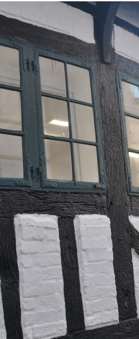
Storegade 11, bevaret bindingsværk fra 1600-tallet. To dokker under hver løsholt, store tømmer dimensioner (midterstolpen på gavlen) og profilerede knægte.
