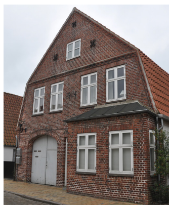
Slotsgade 7, toetagers gavlhuis, grundmuret med karnap og port. Opført i 1914 med stiltræk fra den tyske nationalromantik/Heimatschutz-stil/hjemstavnstil, med mansardtag og murede detaljer.
