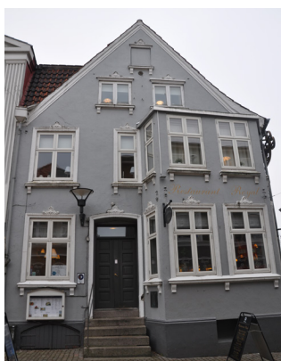
Nørretorv 1, grundmuret med karnap, vinduesindfatninger er trukket i puds og har topornamenter og konsoller under sålbænkene. Nuværende historicistiske udseende stammer fra 1865 ved ombygning af ældre bindingsværkshus.
