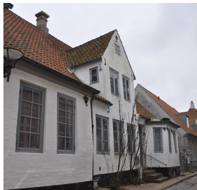
Gildegade 15. Barokt grundmuret langhus med gavkvist og karnapper, liljeformede murankre og murankre med opførelsesåret 1752.
