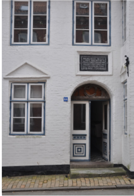
Skibbrogade 8, delvist nyopført i 1752, har som Nygade 50 murede trekantfrontoner over vinduerne. Hustavlen er desuden indrammet.
