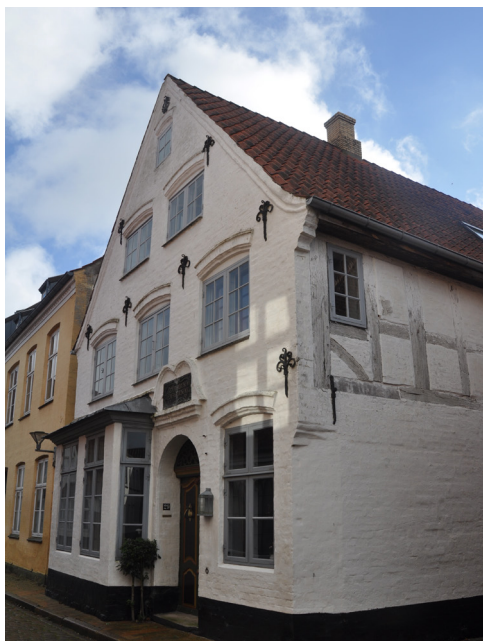
Slotsgade 29. Gavlhuis med barokke træk i to etager, grundmuret gavli med karnap, fladbuede vinduesbryn, dobbeltsvingen fronton over hoveddøren, liljeformede murankre. Bindingsværk på langsiderens 1.sal. Opført 1770 ved delvis ombygning og nybygning.
