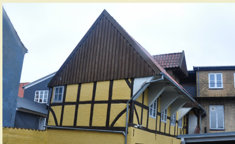
Ramsherred 40, 1863, ombygget pakhus/baghus med bindingsværk i andet stokværk.
