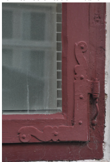
Skibbrogade 3, opr. to huse opført i 1737 og 1748. Hver med karnap i to etager, der fremstår som et fremspringende symmetrisk midterparti. Vinduernes hjørnebåndshængsler er i barok-/rokoko-stil.
