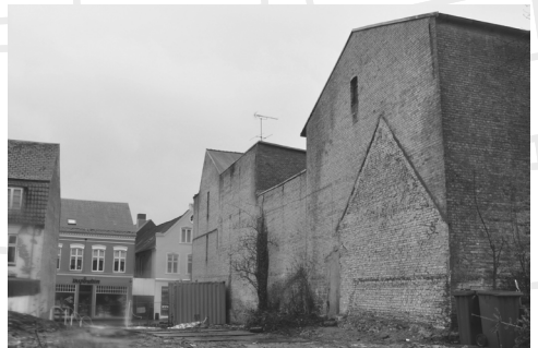
Ramsherred 30. Ved nedrivning bliver byens gamle struktur synlig for alle. Her ses et tydeligt spor af et tværhus' møde med næste matrikels tværhus.
