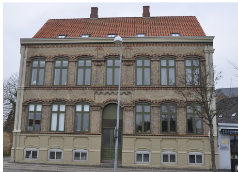
Nyvej 3 er opført i 1857 og fremstår som et fritstående længehus. Huset er grundmuret med historicistiske træk som de rytmisk placerede pilastre og rundbuefrisen over hoveddøren.
