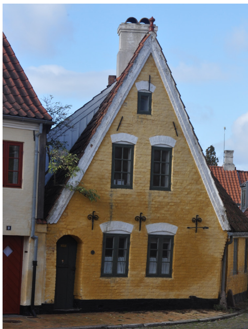
Vægterpladsen 2, Tresuren . Udskilt fra Nygade 33 mellem 1795 og 1803. Grundmuret trefags gavlhuis, liljeformede bjælkeankre og spir med kobberkugle på gavlspidsen. Gul-kalket murværk og sorttjæret sokkel. Muligvis opført ud fra tre inddragede bindingsværksfag fra Nygade 33, 1744-54.
