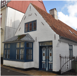
Fiskergade 3, opført før 1744 i bindingsværk, grundmuret o. 1825-35. Enkelt barokt gavlhus med stejlt sadeldelt, enkle murankre og karnap. Ved porten ses muret detalje, der afskærer og beskytter hjørnet.
