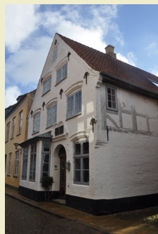
Slotsgade 29, 1770. Bindingsværk bevaret på siden til 1 sal/andet stokværk.
