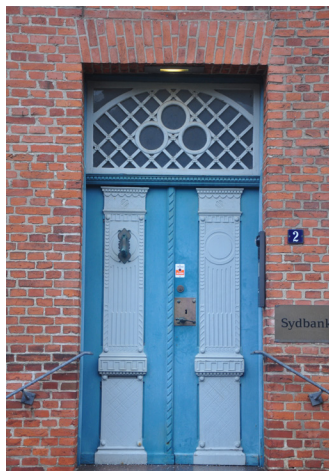
Kirkepladsen 2. Hoveddøren stammer formodentligt fra andet hus, Louis Seize-pilastermotiv, der afsluttes af bladranke og er dekoreret med medaljoner, kanneleringer og tandsnit.
