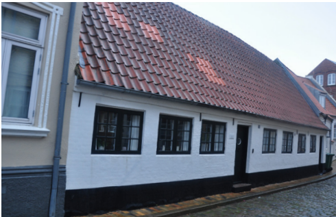
Lille Pottergade 5, opført før 1744 som bindingsværkshus med tre våninger. Mellem 1764 og 1775 er huset delvist omsat til grundmur. Gesims med kvartrunt skifte mellem to retkantede.
