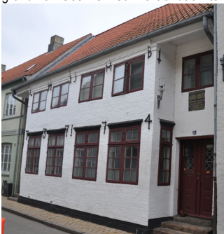
Skibbrogade 3, opr. to huse opført i 1737 og 1748. Hver med karnap i to etager, der fremstår som et fremspringende symmetrisk midterparti. Vinduernes hjørnebåndshængsler er i barok-/rokoko-stil.
