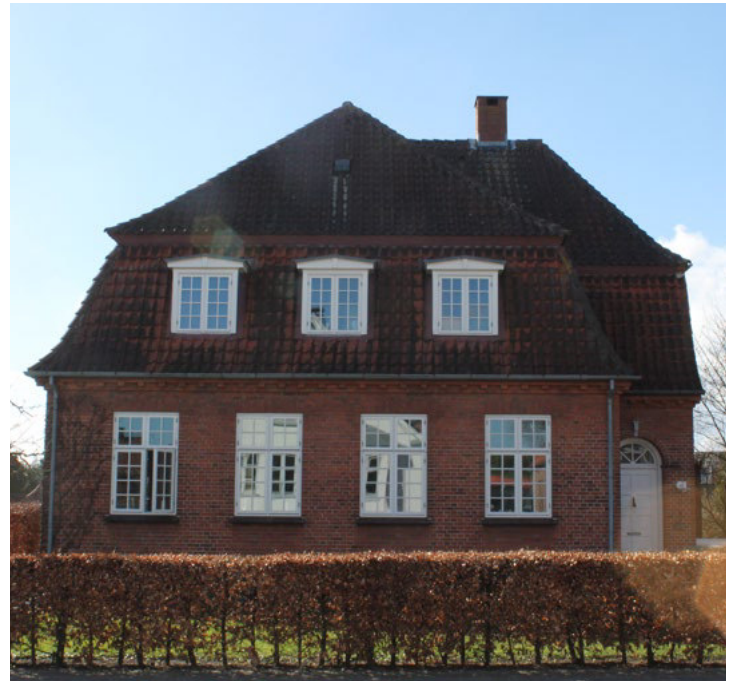
Callesensgade 8, Heltagskviste med lav taghældning, tækket med zink. Placeringen af kvistene underordner sig tagets form og facadens vinduesplacering. Rudeformater er ens.
