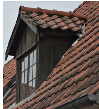
Slotsgade 6, Heltagskvist med tegl og bræddebeklædning.
