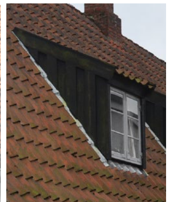
Slotsgade 5, Pultkvist. En-på-to bræddebeklædning og med enkle sugfjæl.
