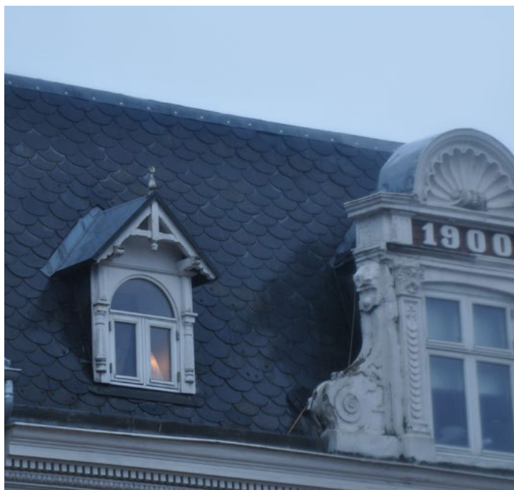
Nørreport 8. Heltagskviste i schweizerstil med udhæng og gavldekoration. Nok oprindeligt tækket med skifer, nu zink. Front også dekoreret med pilasterlignende motiver. Ny-barok frontkvist med fritstående gavler der hviler på hovedhusets gesims, afdækninger med bly.
