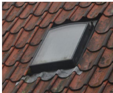
Nybro 3. Enkelt tagvindue placeret lavt i tagfladen og med skjulte inddækninger. Bredden af tagvinduerne er tre tagsten ligesom højden.
