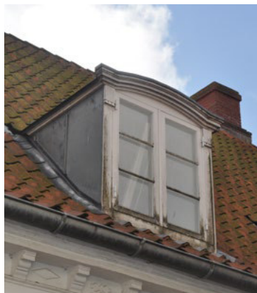
Slotsgade 33. Enkel kvist med buet tag på det klassicistiske hus. Flunke beklædt med lodret falsat zink.
