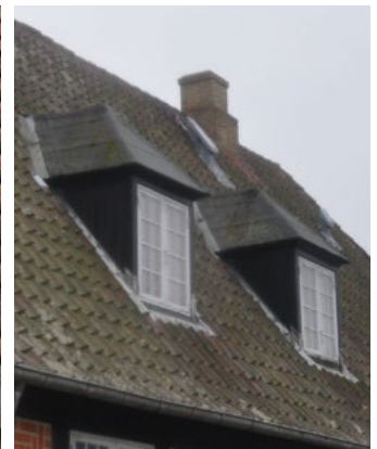
Nybro 14, Heltagskvist med valm. Tækket med tagpap og bræddebeklædning.
