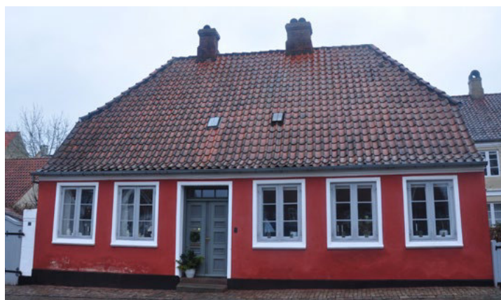
Kirkepladsen 7. Den gamle pigeskoles tagflade har to små støbejernstagvinduer der underordner sig tagfladen fint.
