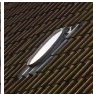
Slotsgade 9. Enkelt ovalt tagvindue placeret lavt i tagfladen og med skjulte inddækninger.
