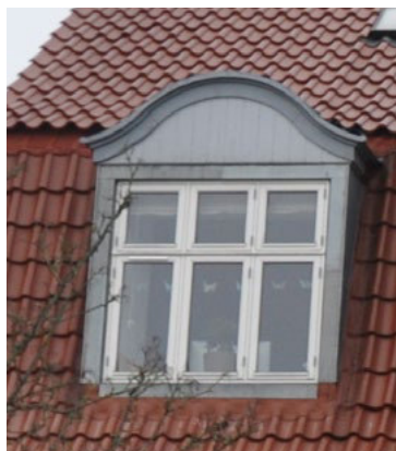
Ramsherred 29. Frontkvist med buet tag tilpasser sig facadens komposition og sidder fint på mansardtagets nedre del.
