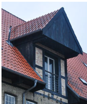
Skolevej 7. Pakhusets hejskvist, med let konstruktion i bindingsværk og breddebeklædte flunke er omdannet til at have vindueshul.
