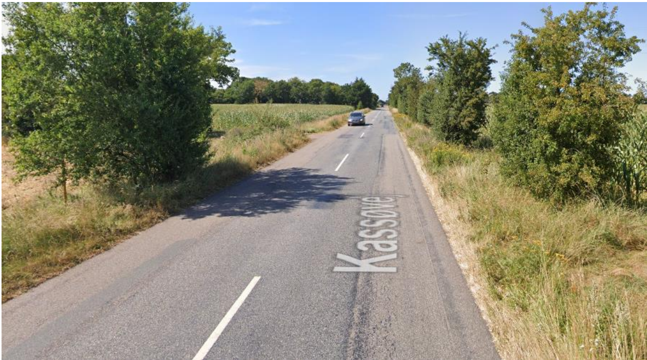
Figur 7-17: Udformning af Kassøvej. Billedet er taget vest for krydsningen med Hellevad-Bovvej i vestgående retning. Kilde: Google Maps. 2020.
