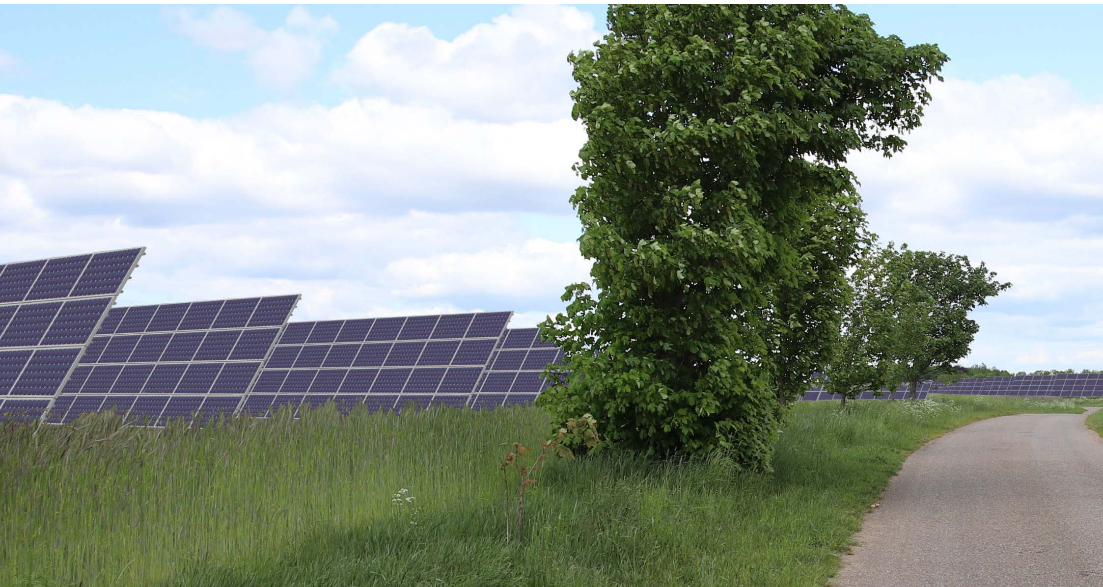
Punkt 6. - Visualiseringen viser de fremtidige forhold med ca. 3,95m høje solceller på trackere - Hjolderup Klintvej - Nærzone Afstanden til solcellerne er ca. 30 m. I denne position opleves solcellerne tydeligt højere end de faste paneller på 3m.
