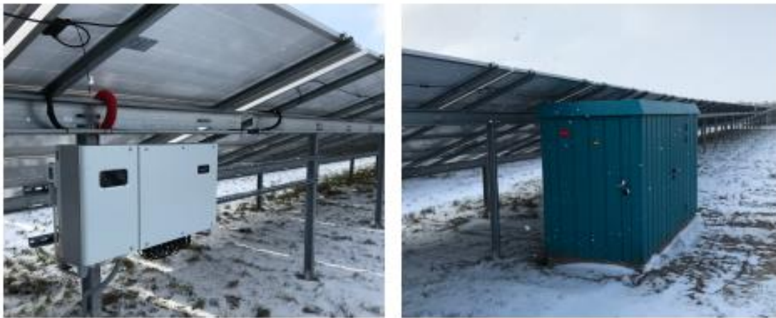
Figur 5-4 Eksempel på inverter (tv.) og transformatorstation/samlehus (th.). De viste anlæg er fra et andet projekt, og anlægstypen i det aktuelle projekt er pt. ikke kendt.
