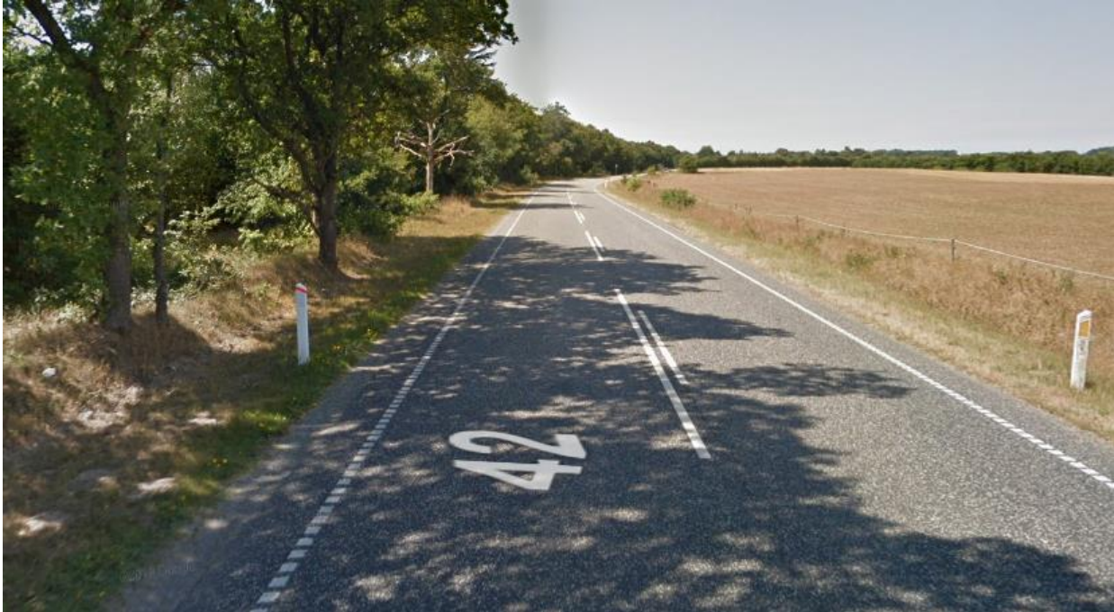
Figur 7-16: Udformning af Tinglevej. Billedet er taget vest for Torp i vestgående retning. Kilde: Google Maps. 2018.
