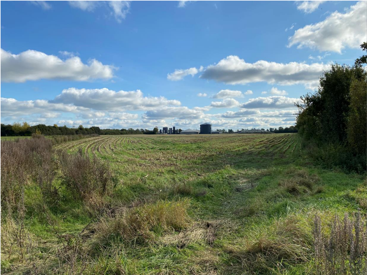
Figur 22: Foto af det eksisterende biogasanlæg taget fra Tågholmvej
