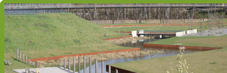
Nyanlagte kanaler i omdannet bypark • Llobregat, Spanien
