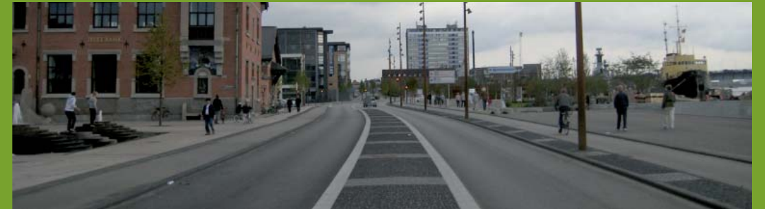
Vejprofilen tilgodeser fodgængere med bred midterhelle og brede fortorve • Aalborg, Danmark
