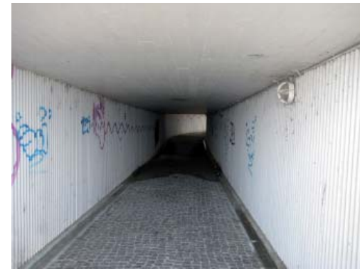
Fodgængerpassage under Kystvej
